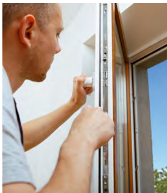
Der Einbau von Fenstern durch einen Fachbetrieb bietet entscheidende Vorteile.
